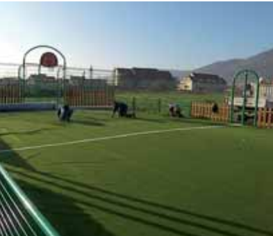
Châtenois – mise en place du gazon.
