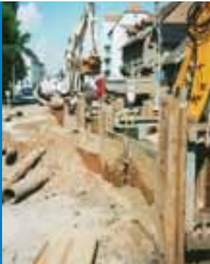
Chantier du collecteur d'assainissement.
