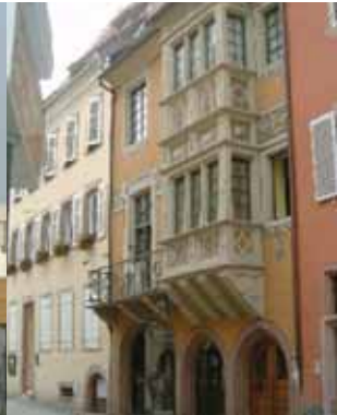
Façade réhabilitée dans le cadre de l'OPAH (rue des Chevaliers, Sélestat).
